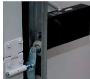
Controllo della rottura cavo. Cable safety check.
